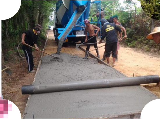
โครงการก่อสร้างถนนคอนกรีตเสริมเหล็ก
