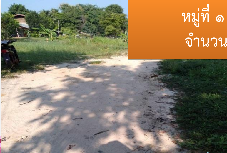
โครงการก่อสร้างถนน
